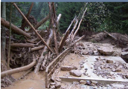
Bild 22: Verklauung an einer Brücke.
