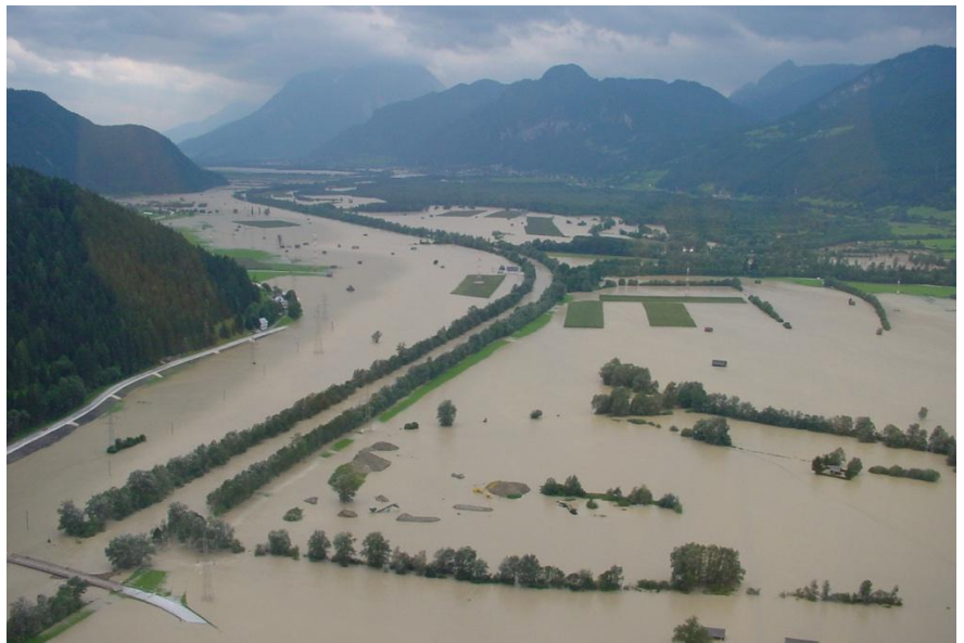
Bild 12: Überflutung durch Hochwasser der Enns in Liezen 2002. © Fachabteilung 14 Hochwasserrisikomanagement, Land Steiermark.
