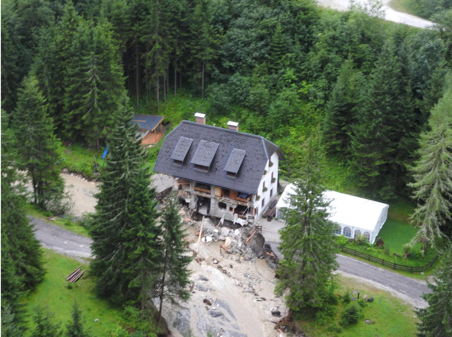
Bild 24: Das Berghaus in der Walchen bei Öblarn wurde bei der Unwetterkatastrophe 2017 vom Hochwasser führenden Walchenbach schwer beschädigt. © Wildbach- und Lawinerverbauung (WLV), Forsttechnischer Dienst.
